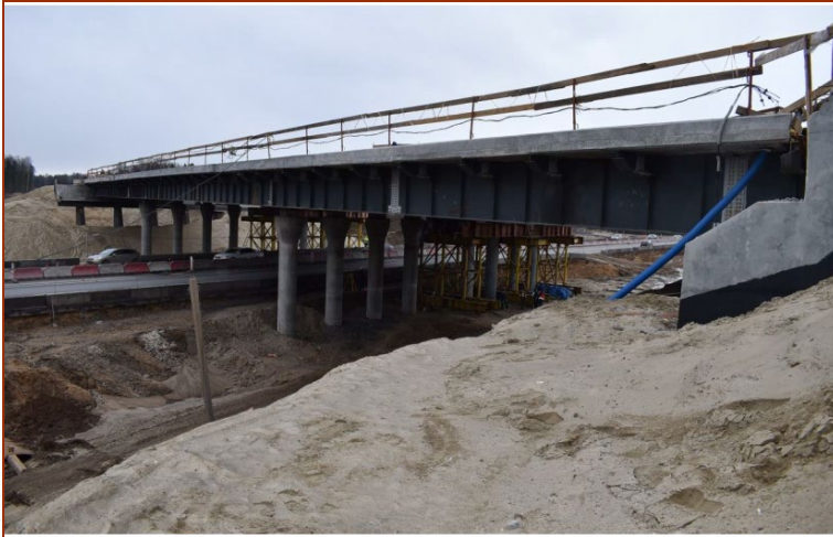
Рисунок 1.1. Общий вид путепровода со стороны опоры №1, слева
