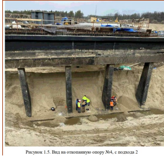
Рисунок 1.5. Вид на откопанную опору №4, с подхода 2
