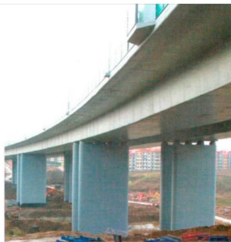
Рис. 1. Общий вид моста-эстакады
