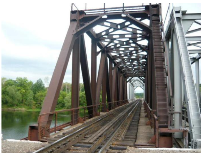
ЖД мост через р.Ворона ЮВЖД
