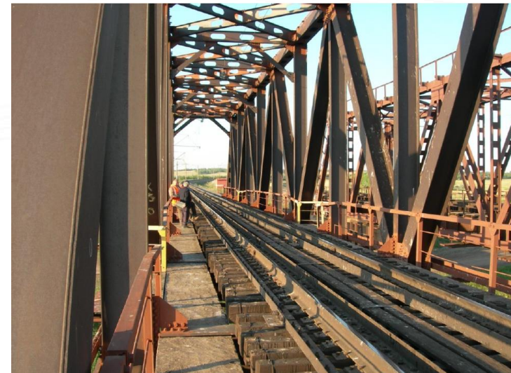
ЖД мост через р. Камышлы-Аят ЮУЖД
