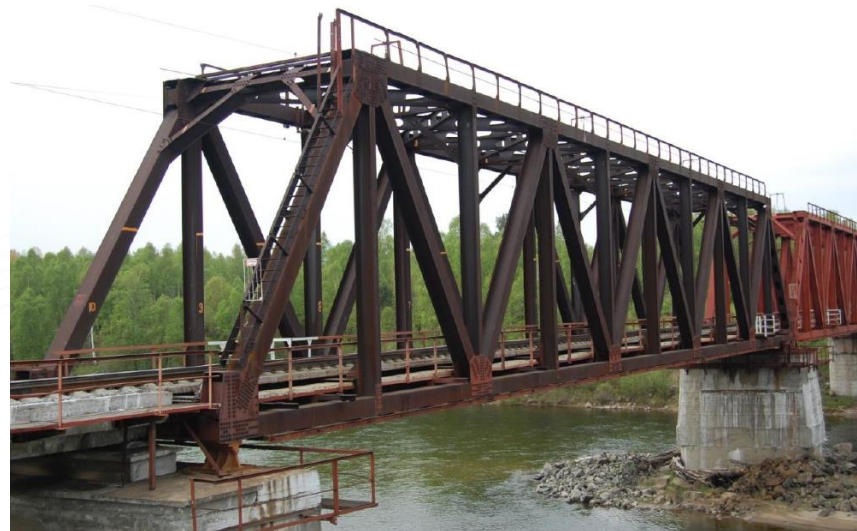
ЖД мост через р. Снежная ВСЖД
