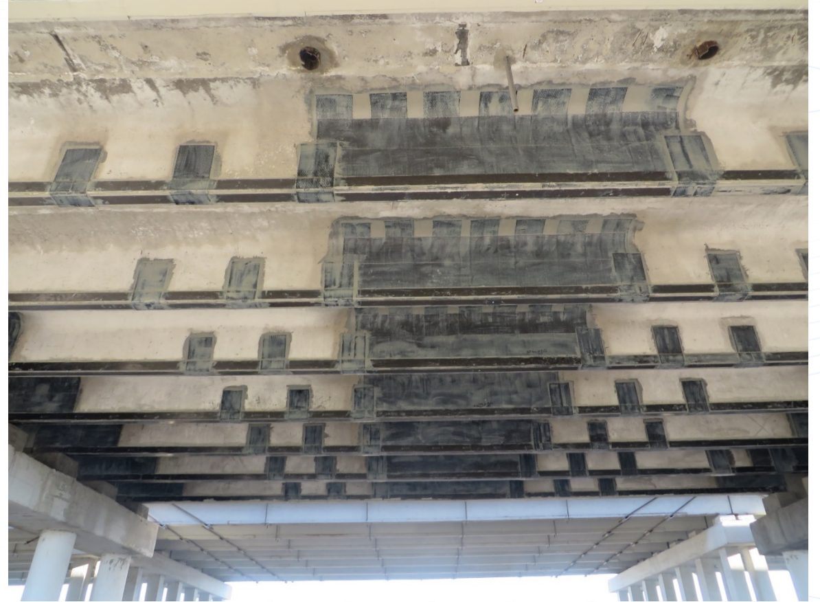
Наклейка углепластиковых ламелей
